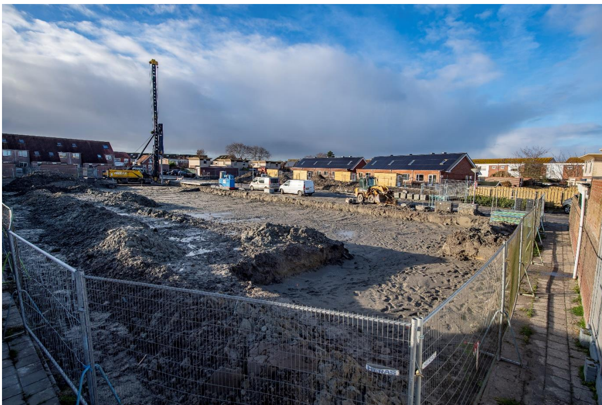
De eerste palen zijn de grond in voor de nieuwbouw aan de Henri Dunantstraat. Op de achtergrond de nieuwe woningen aan de Jacoba van Beierenstraat.
