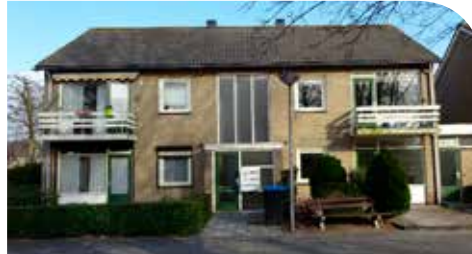
voor de renovatie
