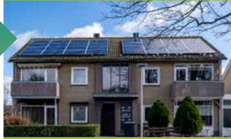
na de renovatie
