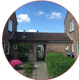
Overdekte doorgang naar achterterrein
